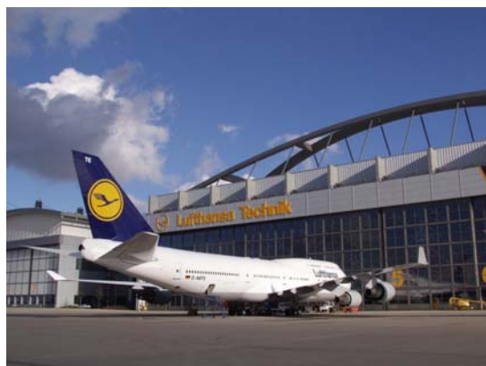
Die Jumbohalle der Lufthansa Technik AG in Hamburg (Quelle: Lufthansa Technik AG).
